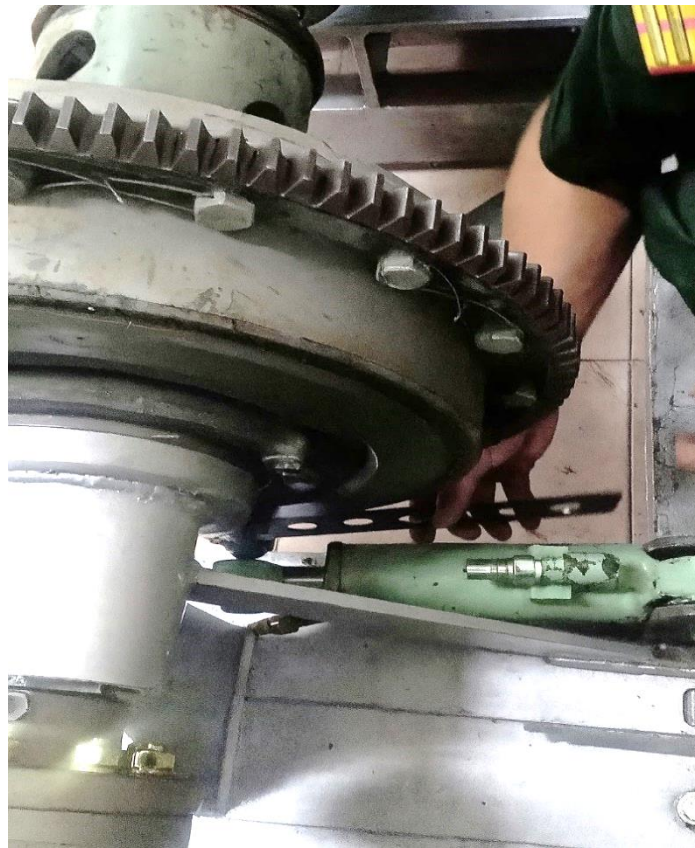
Hình 3.15. Lắp đặt cảm biến PRT18-8DO và xy lanh điều khiển
