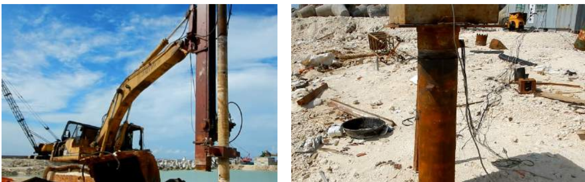
Hình 2.13. Hạ cọc và thí nghiệm cọc ống thép có gắn thiết bị đo tại hiện trường nghiên cứu ma sát cọc ống thép và nền san hô [6]
