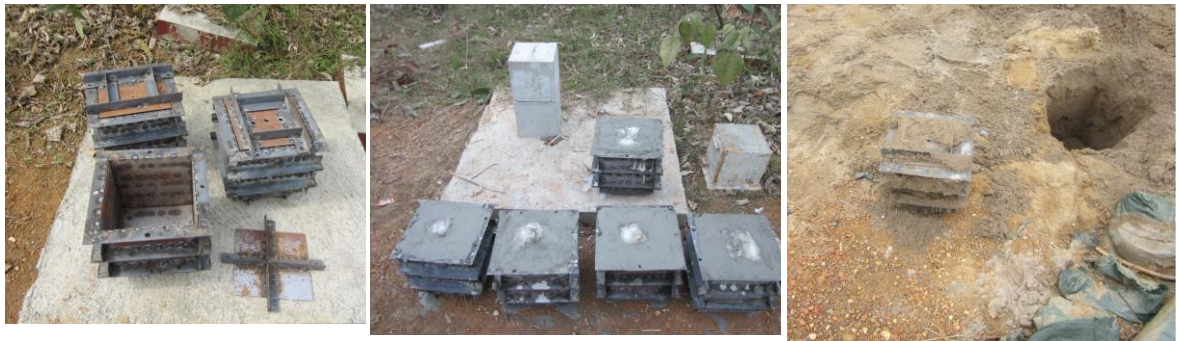
Hình 4.11. Hình ảnh mẫu thí nghiệm loại A tại hiện trường
