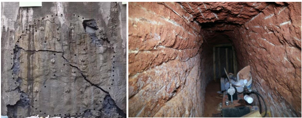
Hình 1.6. Nổ mìn tạo mặt nhẵn ở biên đường hầm
