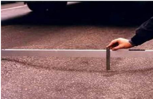
a. LVBX mặt đường tại Nam Kinh - Trung Quốc
