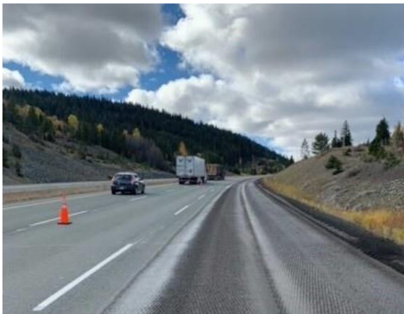
d. LVBX mặt đường tại cao tốc Coquihalla, Canada
