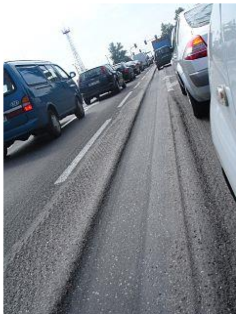
c. LVBX mặt đường tại Silesian Voivodeship, Ba Lan
