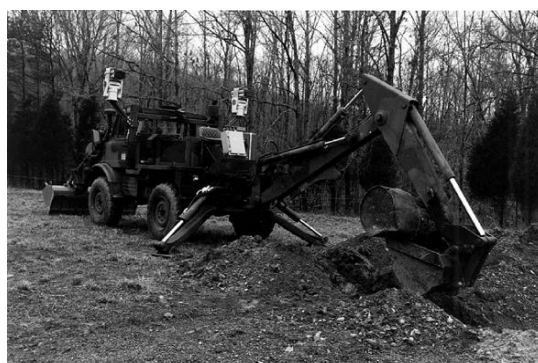
Hình 1.5. Máy đào thủy lực ĐKTX của nhóm Burks
