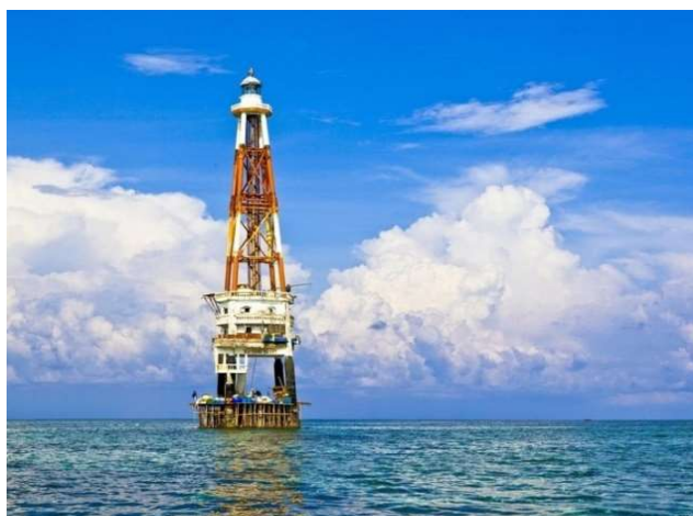
Hình 0.2. Công trình ngọn hải đăng trên đảo Đá Lát - Trường Sa.
