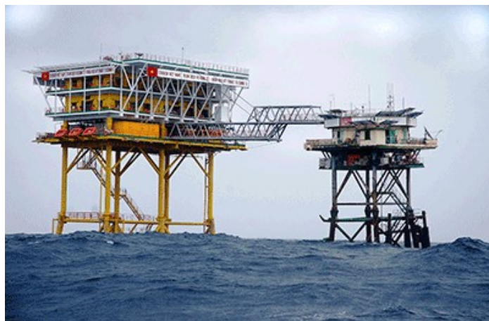
Hình 0.4. Công trình nhà dầm DKI.
