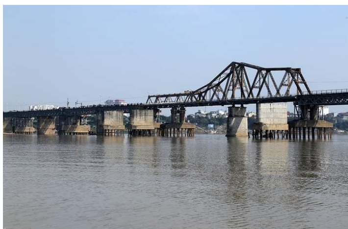
Hình 0.1. Công trình cầu Long Biên - Hà Nội
