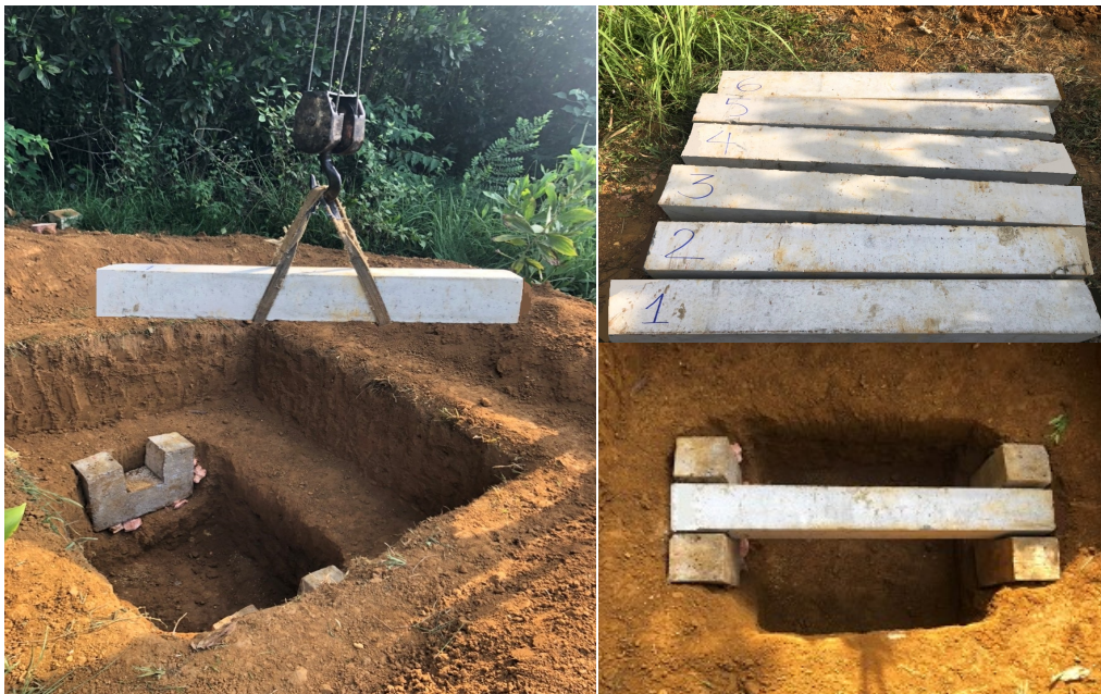
Hình 3.1. Cấu kiện cột bê tông cốt thép và gói đỡ thí nghiệm
