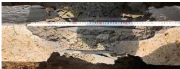
Hình 3.20. Cấu kiện BTCT số 5 bị phá hủy sau khi nổ tiếp xúc
