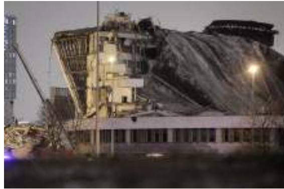
Hình 1.8. Sập đổ mái sân vận động Saint Petersburg do lỗi thi công, Nga năm 2020
