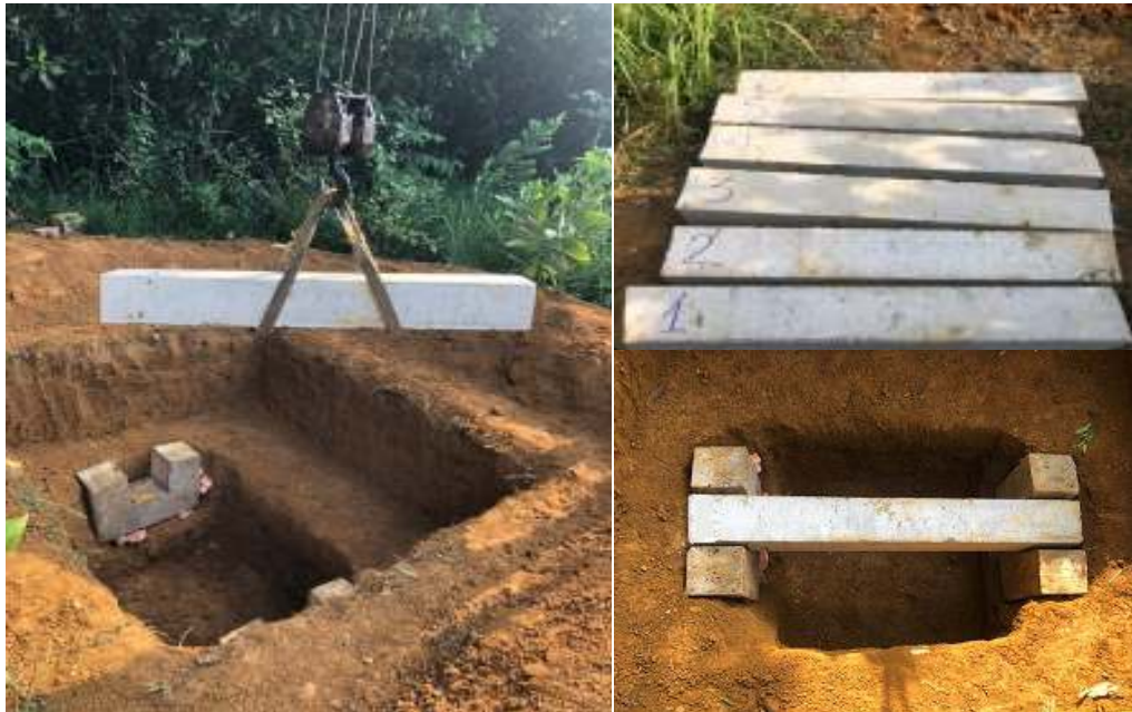
Hình 3.9. Cấu kiện cột bê tông cốt thép và gô đỡ thí nghiệm
