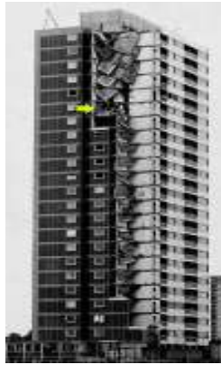
Hình 1.3. Sập đổ tòa nhà Ronan Point ở Luân Đôn do nổ khí ga năm 1968
