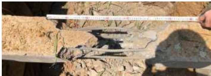
Hình 3.18. Cấu kiện BTCT số 2 bị phá hủy sau khi nổ tiếp xúc
