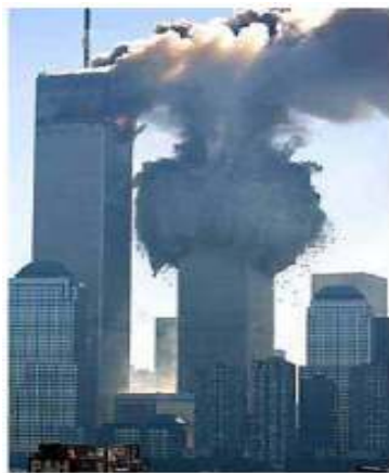
Hình 1.5. Sập đổ tòa tháp WTC, New York do không tặc tấn công năm 2001
