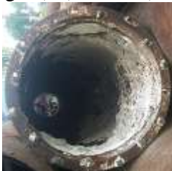
Hình 1.7. Cọc ống thép hạ đầu tiên gắn răng cắt
