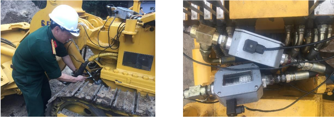
Hình 4.17. Lắp đầu đo lưu lượng R4S-7HD, đầu đo cảm biến áp suất OCM-511
