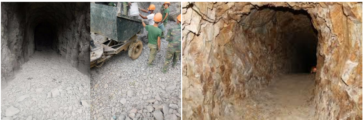
a) Đường hầm sau khoan nổ b) Bốc xúc ĐNM trong đường hầm c) Đường hầm sau khi bốc xúc
