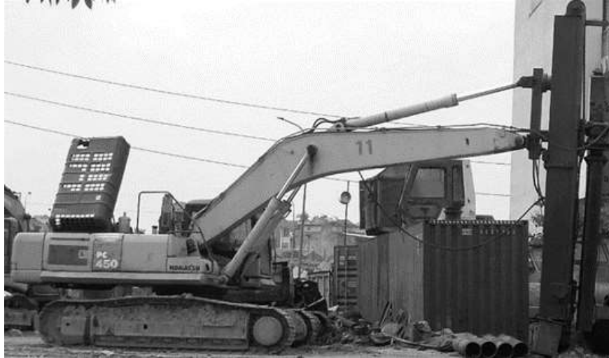
Hình 4.3. Bộ công tác lắp trên máy xúc PC- 450 làm thực nghiệm tại đảo Trường Sa lớn
