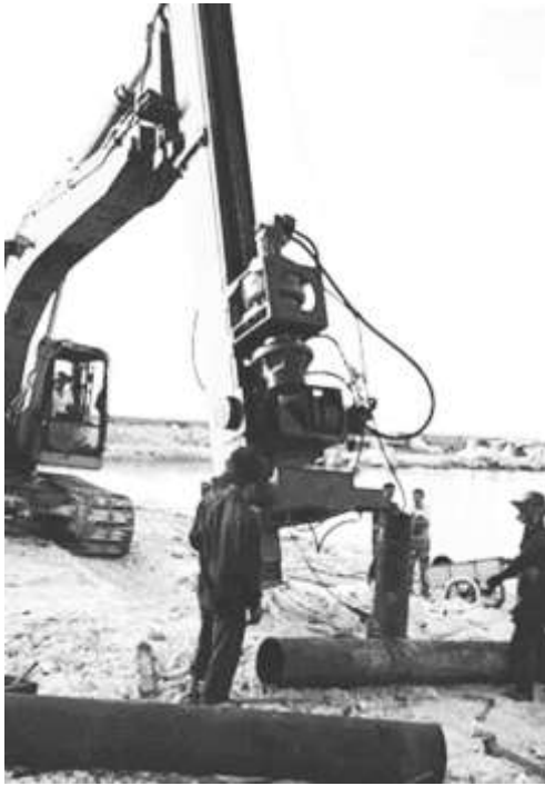
a - Tập kết máy ra vị trí thực nghiệm
