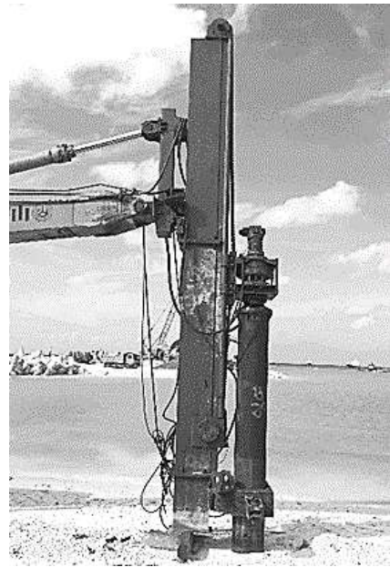
d – Định vị máy thực nghiệm hạ cọc
