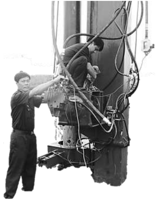
b – Lắp đặt các đầu đo
