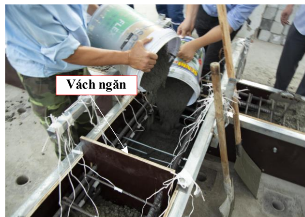
d) Đổ bê tông
