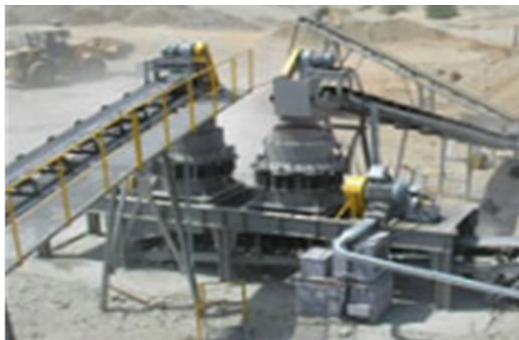
Hình 1-1. Tổ hợp nghiền sàng đá công suất lớn
